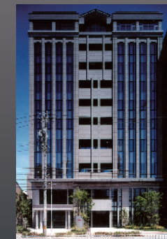
本社ビル外観
